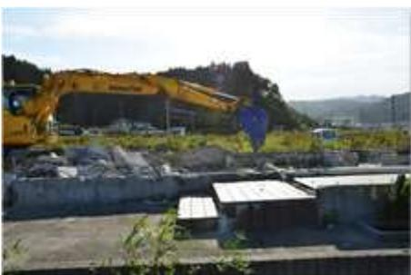
かさ上げ区域では住宅基礎の撤去工事が町内のいたる所で進められています。その後、かさ上げ工事が始まる予定です。
