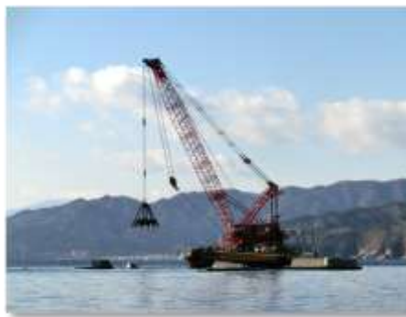
町内各海岸では護岸改修工事が進められています。
