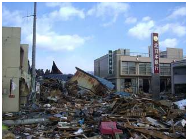
岩手県山田町 発災直後の様子 [現地スタッフ 撮影]
